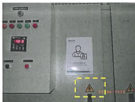
รูปที่ 21 ป้ายเตือน “อันตรายไฟฟ้าแรงสูง” ที่จุดติดตั้งหม้อแปลง
