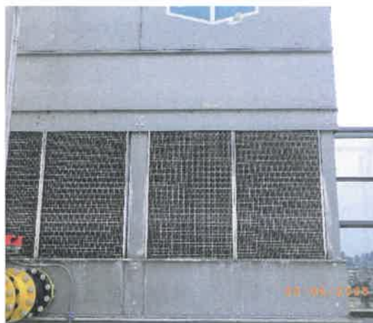
รูปที่ 47 อุปกรณ์ป้องกันการฟุ้งกระจายของละอองน้ำจากท่อผึ่งเย็น
